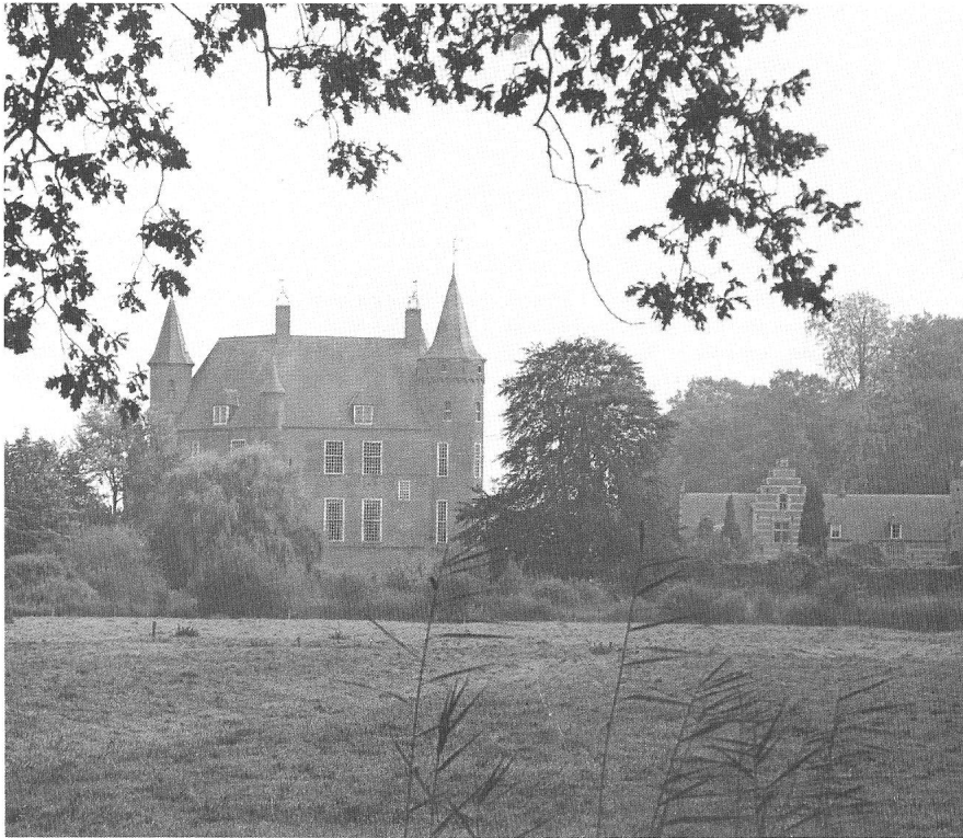
Kasteel Heeswijk; rechts de voorburch. Noord.gevels ná de restauratie van 1951.
